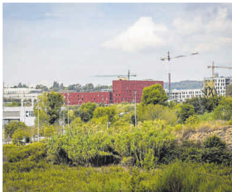
Terrenys al Parc de l'Alba en procés de construcció.
