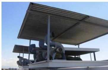
Teulada de protecció a coberta
