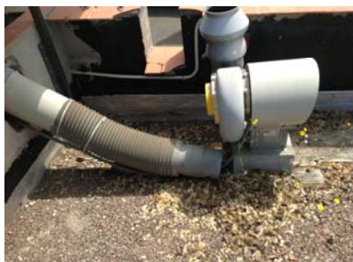
Exemple de deficiències detectades durant les tasques de manteniment preventiu
