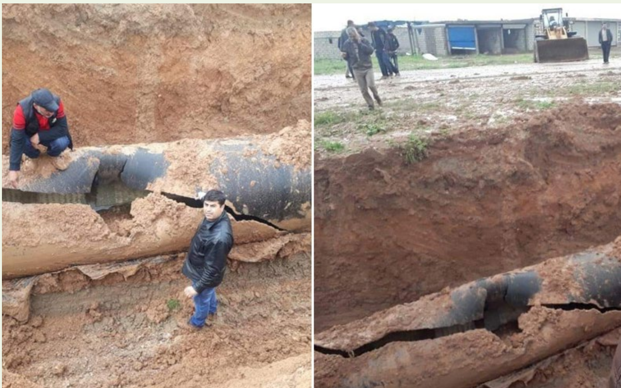
La canonada principal de la planta d'aigua d'Alluk va ser damnificada a causa del bombardeig amb artilleria per part de Turquia i els seus aliats. Font: Syrians for Truth and Justice.
