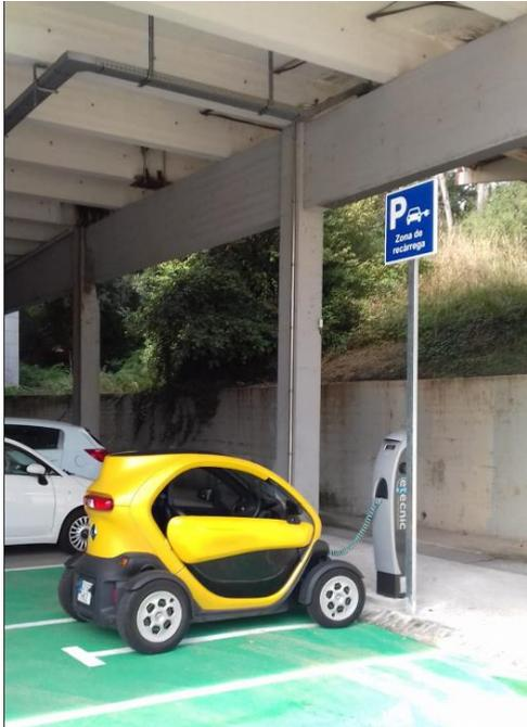
Se trata del primer punto de recarga público en el Campus de la UAB adaptado a coche y moto. Con una potencia máxima de 22Kw, lo que significa poder cargar en un tiempo de entre 2 y 3 horas, según el modelo de coche, y hasta 2 vehículos de forma simultánea. Un sistema inteligente que permite retener y bloquear el cable para evitar la sustracción por parte de personas no autorizadas; y monitorizar y controlar remotamente el uso, además de obtener estadísticas de consumo.
