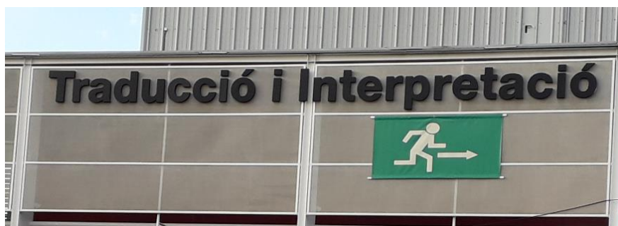
Imatge 22. Senyalització via evacuació
