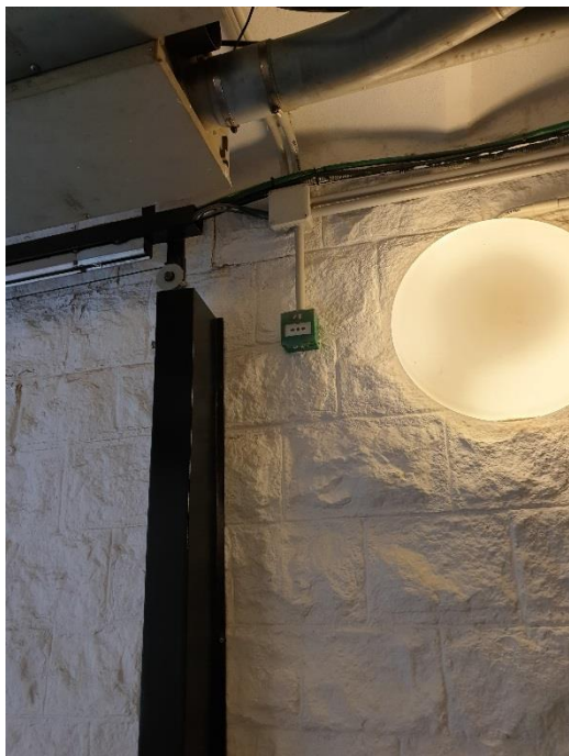
Foto 7 Polsador elevat i no senyalitzat
